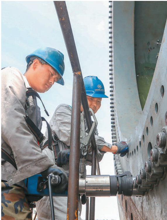
江苏省盐城市射阳港经济开发区CQC新能源创新基地为风电叶片、主机提供全流程检验检测及认证等服务，可同时开展4只150米级全尺寸叶片测试。图为工人正在加紧安装风电叶片。
