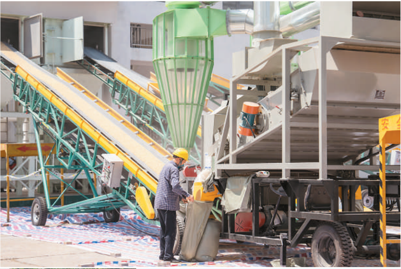
上图:中储粮长沙直属库内,工人在处理粮食入库作业中分离出的杂质。
