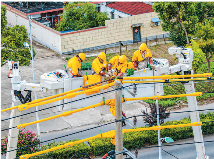
在江苏省扬州市江都区郭村镇,电力工作人员进行搭接引线作业。 任飞摄(人民视觉)
