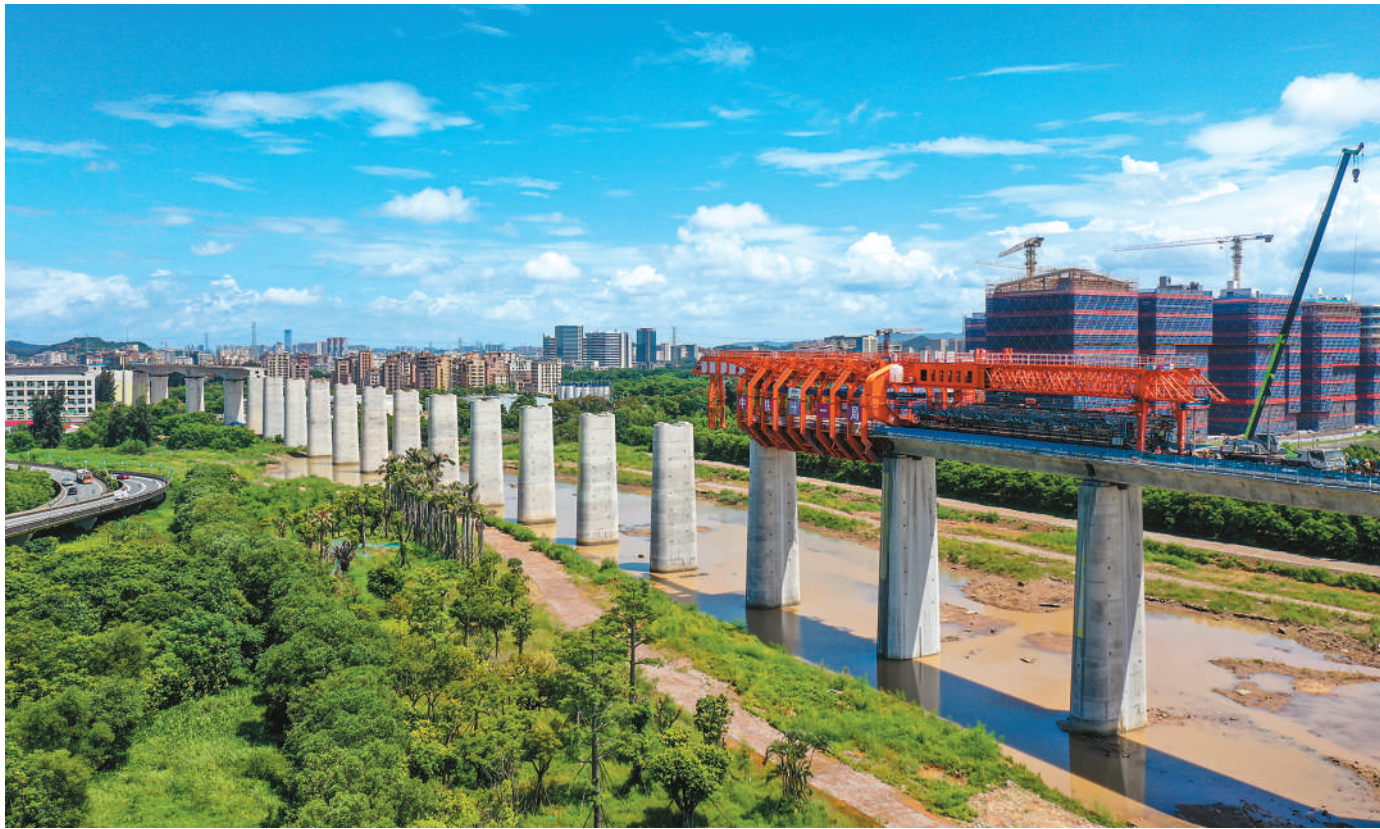
连日来，在位于广东东莞的深江铁路跨沿江高速特大桥建设现场，施工人员有序进行桥梁施工，大桥建设稳步推进。深江铁路是国家“八纵八横”高铁网沿海通道的重要组成部分，建成通车后，深圳与江门可实现1小时内通达，并将与广深港高铁连接，对进一步打造“轨道上的大湾区”具有重要意义。图为深江铁路跨沿江高速特大桥建设现场。 闵 辉摄（人民视觉）
