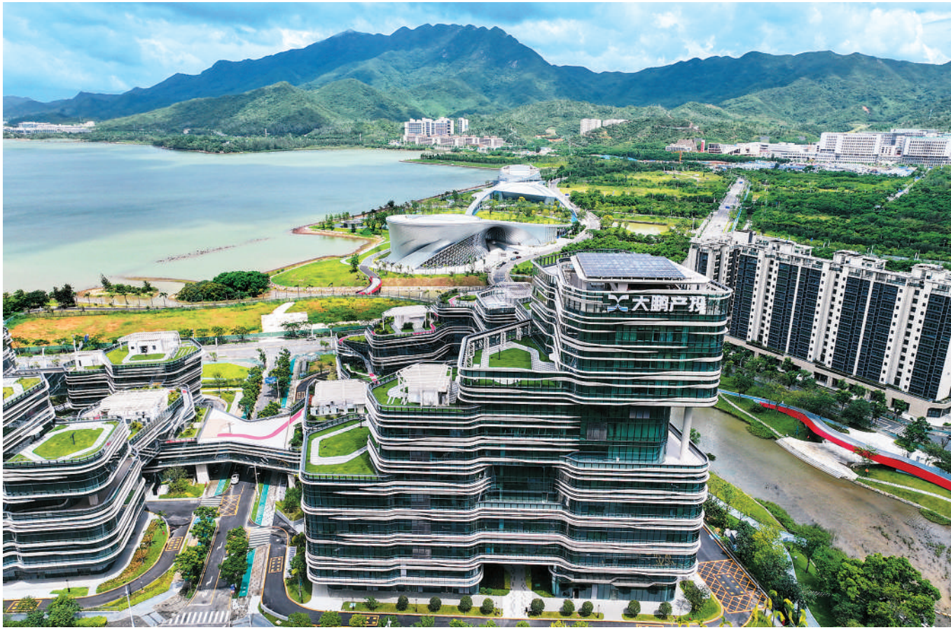
近日，由深圳市大鹏新区产业投资集团投资建设的深蓝科技园圆满竣工并顺利通过验收。该项目位于广东省深圳市大鹏新区，以自然之道为设计理念，6栋建筑群落从绿意中生长而出，将现代建筑美学与山海生态格局有机融合。图为深蓝科技园一隅。
