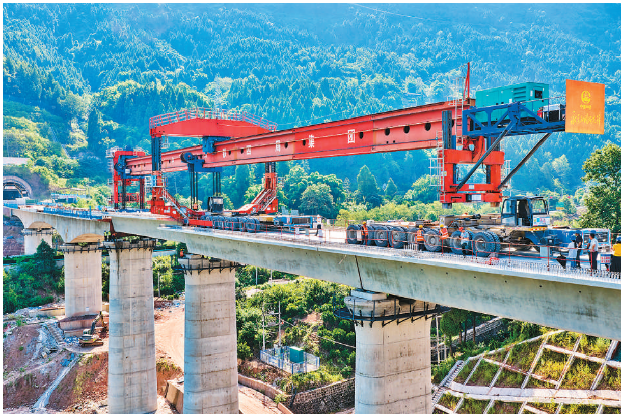
7月14日，随着最后一孔长32米、重约700吨的箱梁精准落位四川省达州市境内的西渝高铁场坝村跨恩广高速公路大桥桥墩，西渝高铁全线箱梁架设任务顺利完成，为全线按期通车奠定坚实基础。西渝高铁是陕西西安至重庆的高速铁路，全长739公里，是中国“八纵八横”高铁网京昆通道和包（银）海通道的重要组成部分。图为架梁施工作业现场。 史家民摄（人民图片）
