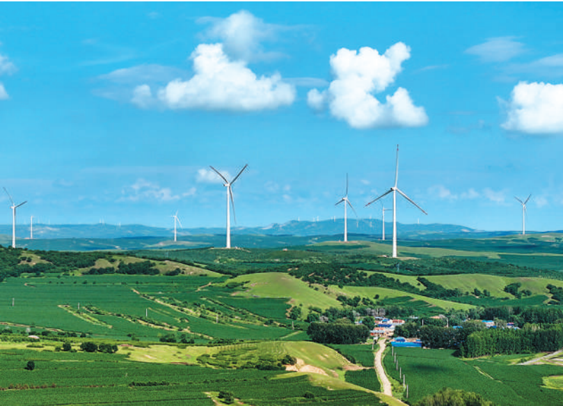
7月13日，在内蒙古自治区扎兰屯市中和镇红星村，一台台风力发电机正在运转。 韩颖群摄（人民视觉）
