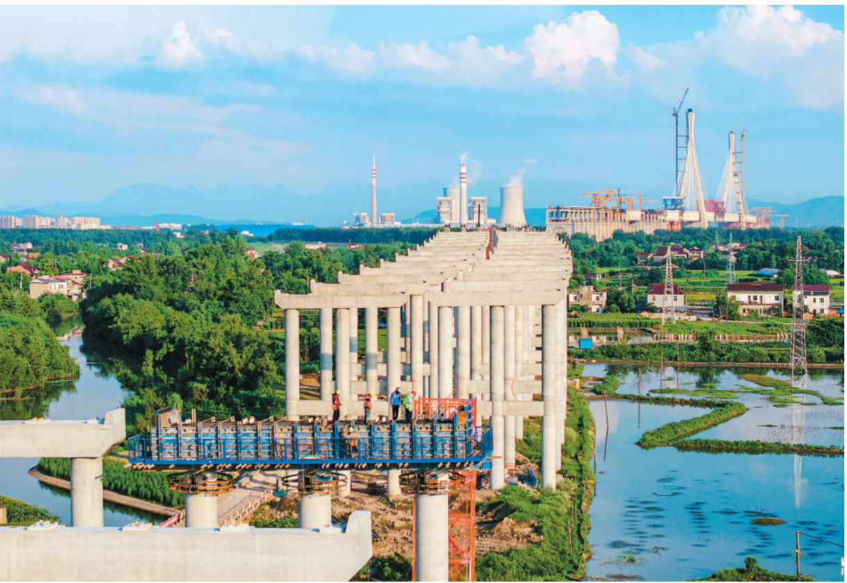
S40安徽宁国至枞阳高速公路铜陵段总长约19.7公里,贯穿铜陵市郊区、枞阳县等多个乡镇村落,建成后将进一步加密皖江地区高速通道,完善市域路网体系。图为宁枞高速铜陵段一标项目现场,工人正在进行桥梁墩柱施工。 刘伯顺摄(人民图片)
