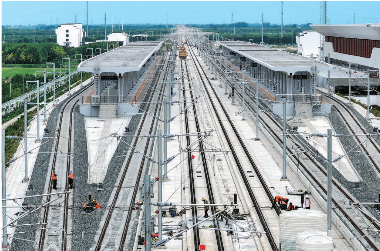
近日，新建安徽阜阳至蒙城至宿州(淮北)铁路(以下简称“淮阜高铁”)正式启动静态验收工作，标志着该高铁主体工程建设基本完成，向着开通运营目标迈出重要一步。淮阜高铁是皖北地区城际铁路网的重要组成部分，新建正线全长约142.5公里。图为工人在位于亳州市蒙城县的淮阜高铁建设现场施工。 胡卫国摄(人民图片)
