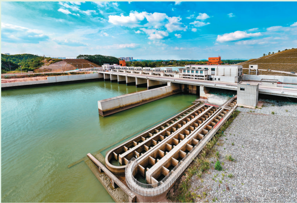
平陆运河青年枢纽的鱼道。
