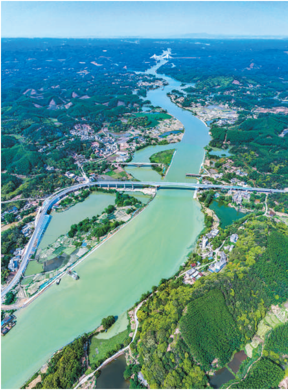
平陆运河航道工程。平陆运河集团供图
