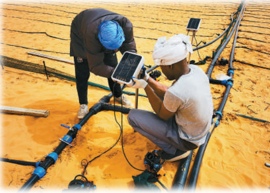
毛里塔尼亚员工在项目园区安装智能灌溉网关及电磁阀。
