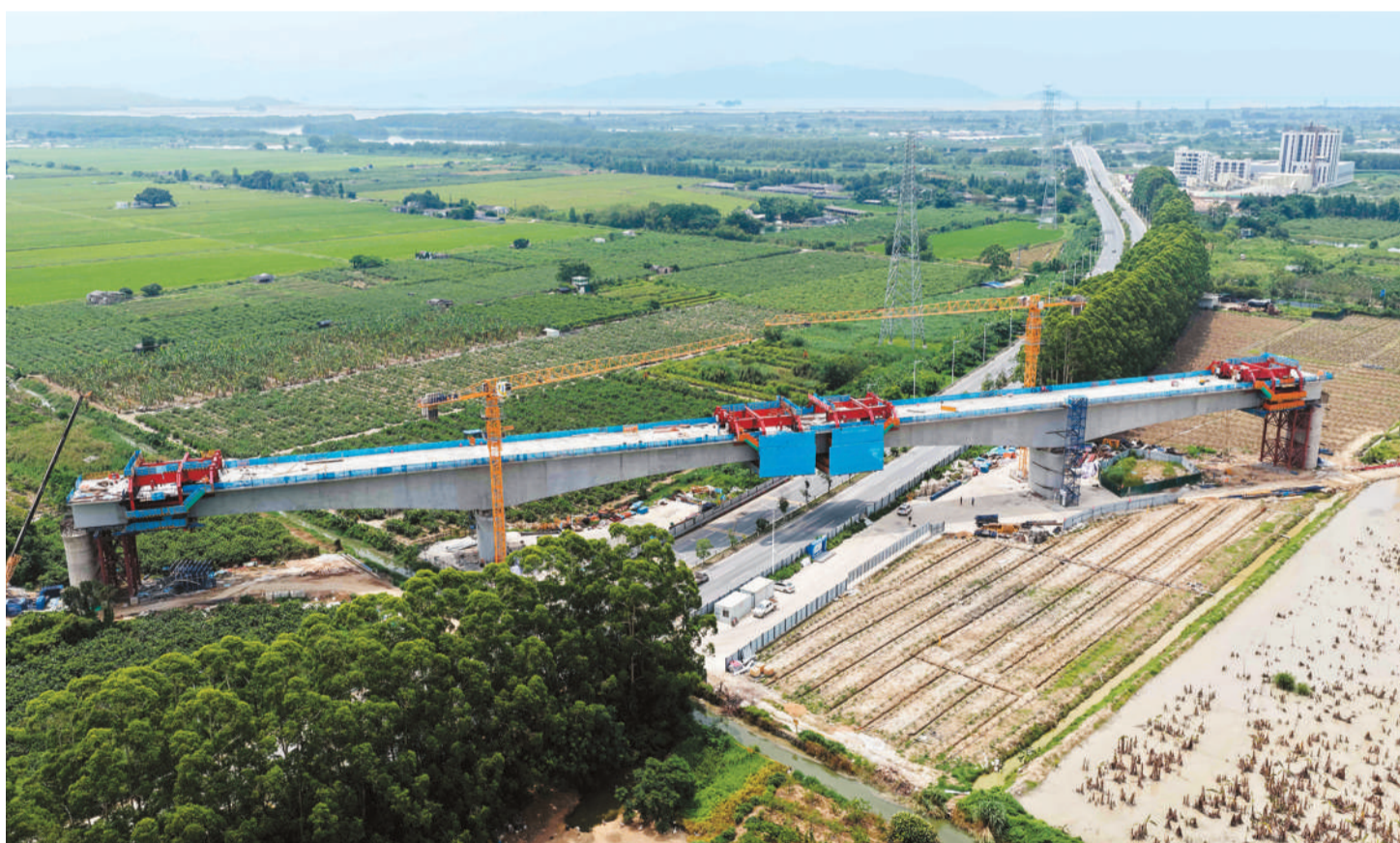
日前，漳汕高铁广东段全面启动桥梁架桥施工。新建漳州至汕头高速铁路北起福建省漳州市漳州站，南至广东省汕头市汕头站，设计时速350公里。建成通车后，将与福厦高铁、广汕高铁等共同组成沿海大通道，进一步完善区域路网结构，助力国家东部沿海地区高质量发展。图为施工现场。新华社记者 邓华摄
