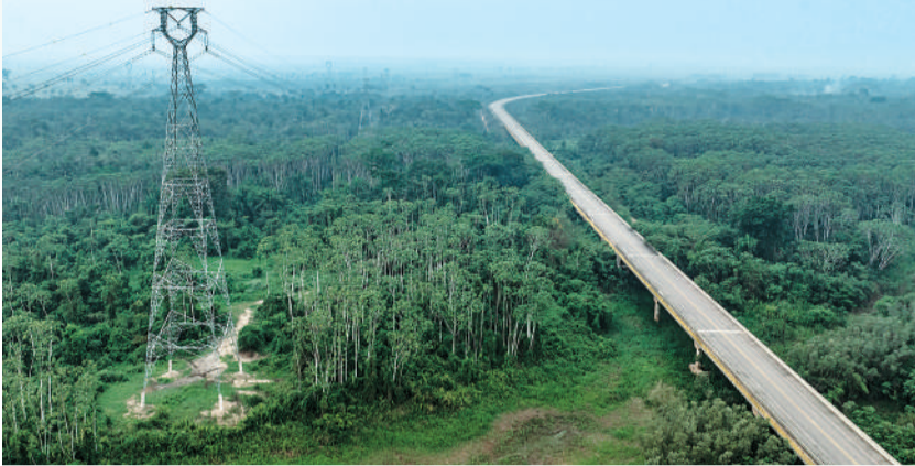
在巴西多尼亚亚,由中国企业承建、中巴双方协同建设的EDP输电变电项目线路穿越热带雨林。
