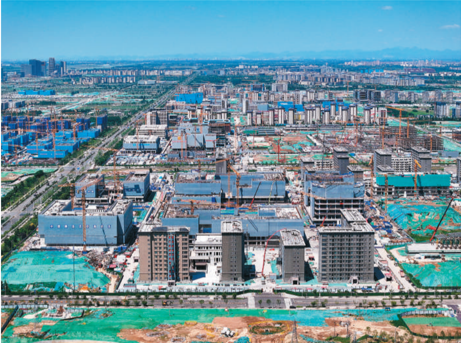
初夏时节，河北雄安新区起步区第五组团北部，首批4所疏解高校雄安校区建设正酣。各参建单位严格把控施工节点计划，高标准、高质量推进项目建设。 图为建设现场，由远及近依次为北京交通大学雄安校区、中国地质大学（北京）雄安校区、北京科技大学雄安校区和北京林业大学雄安校区。 新华社记者 牟 宇摄
