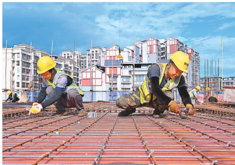
上图：5月25日，在富加镇农贸市场项目建设现场，工人正绑扎板面钢筋。
