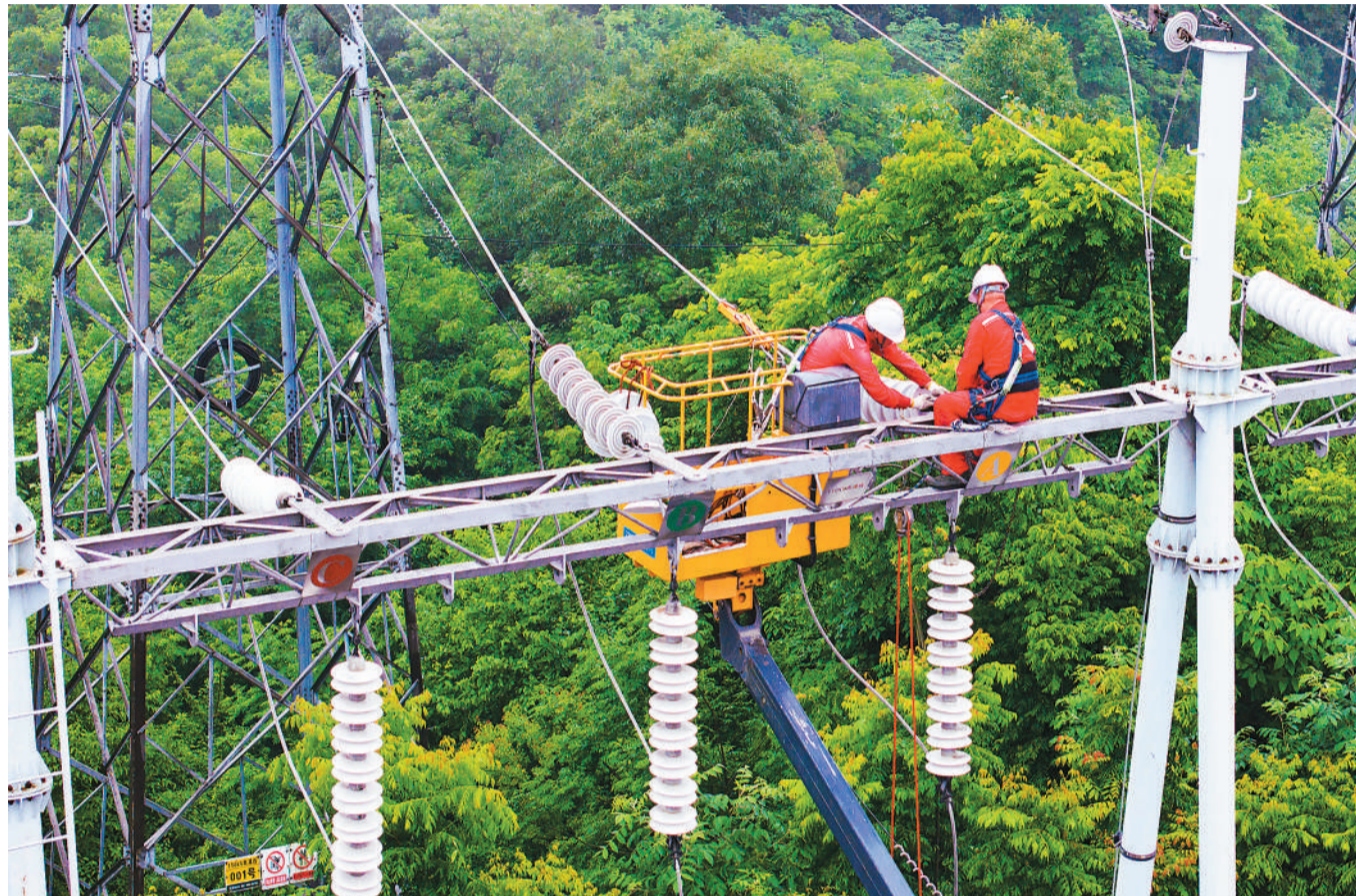
在湖北省荆门市东宝区辖区，电力检修人员对二百二十千伏南桥变电站进行检修作业，保障供电设备安全稳定运行。 黄林摄（人民视觉）
