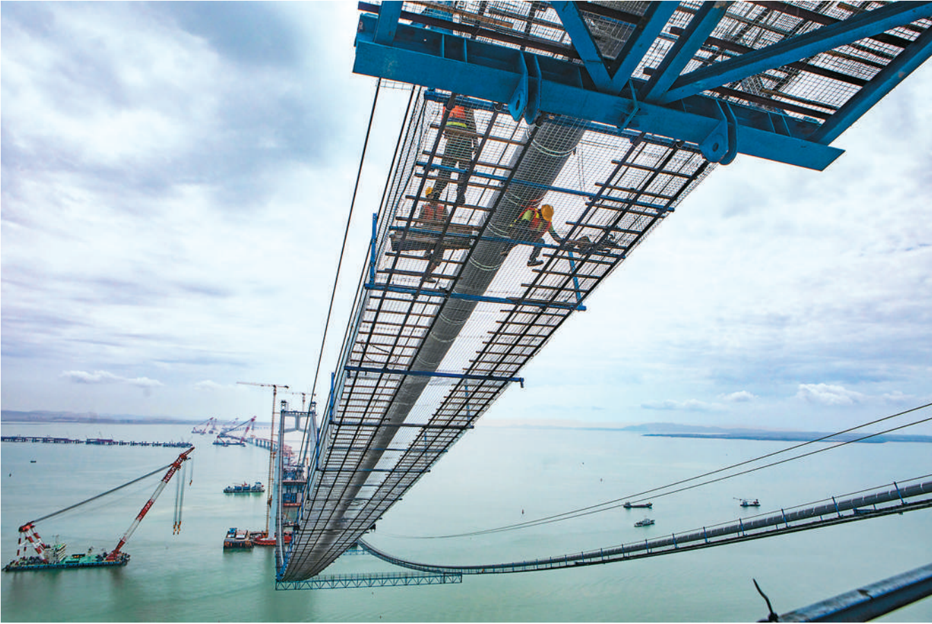
厦金大桥（厦门段）由海上桥梁和陆地隧道两部分组成，建成通车后将成连接厦门本岛与厦门翔安国际机场的最便捷通道。图为近日拍摄的厦金大桥刘五店航道桥施工现场。 王 娟摄（人民图片）
