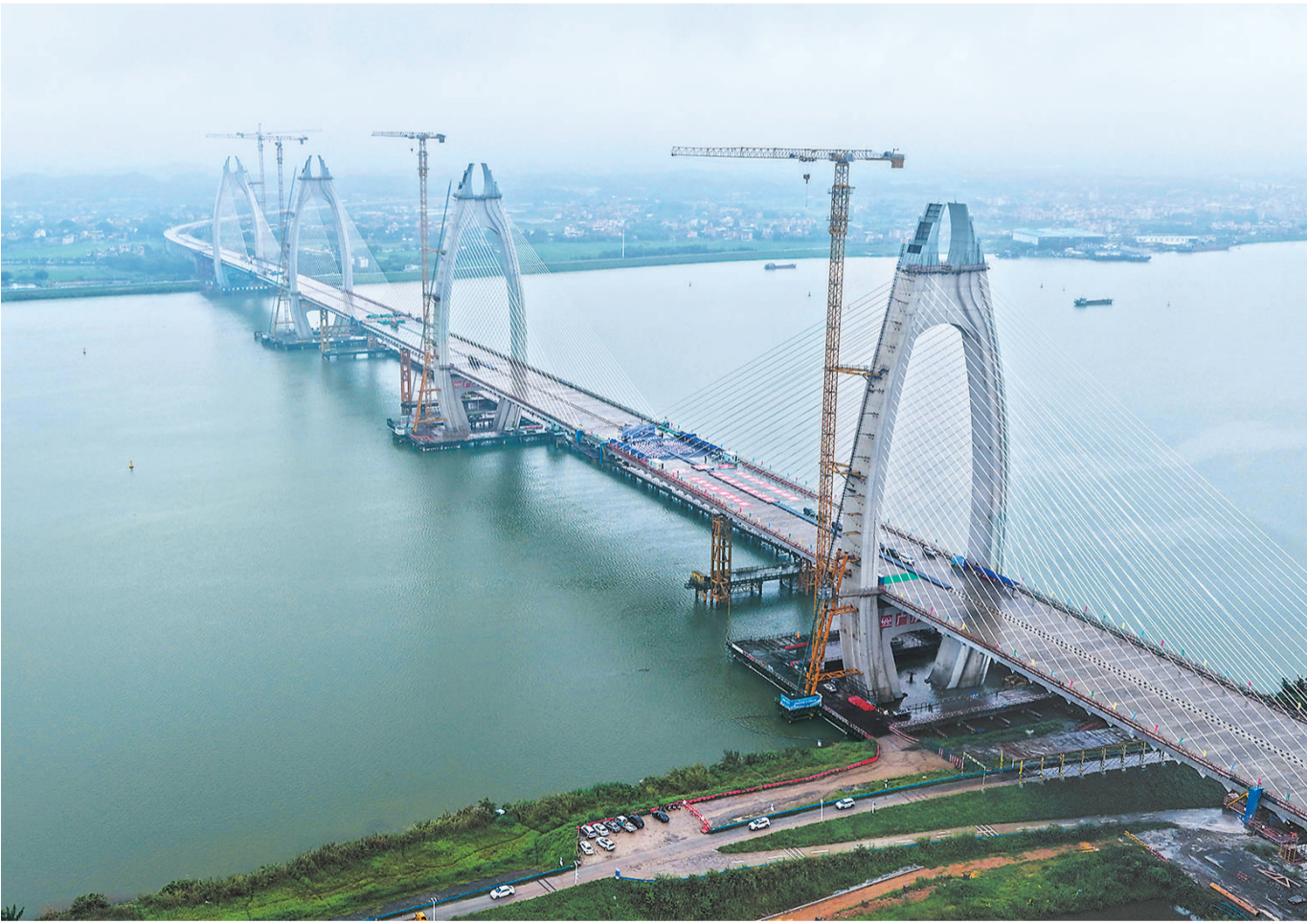
5月20日，广东清花高速关键控制性工程——北江特大桥主桥顺利合龙。清花高速北江特大桥主桥全长1440米，作为广东省“十四五”重点建设项目，清花高速起于清远市清新区太和镇，终于广州市花都区炭步镇，全长约54公里，建成后将成为广清一体化又一交通大动脉。
