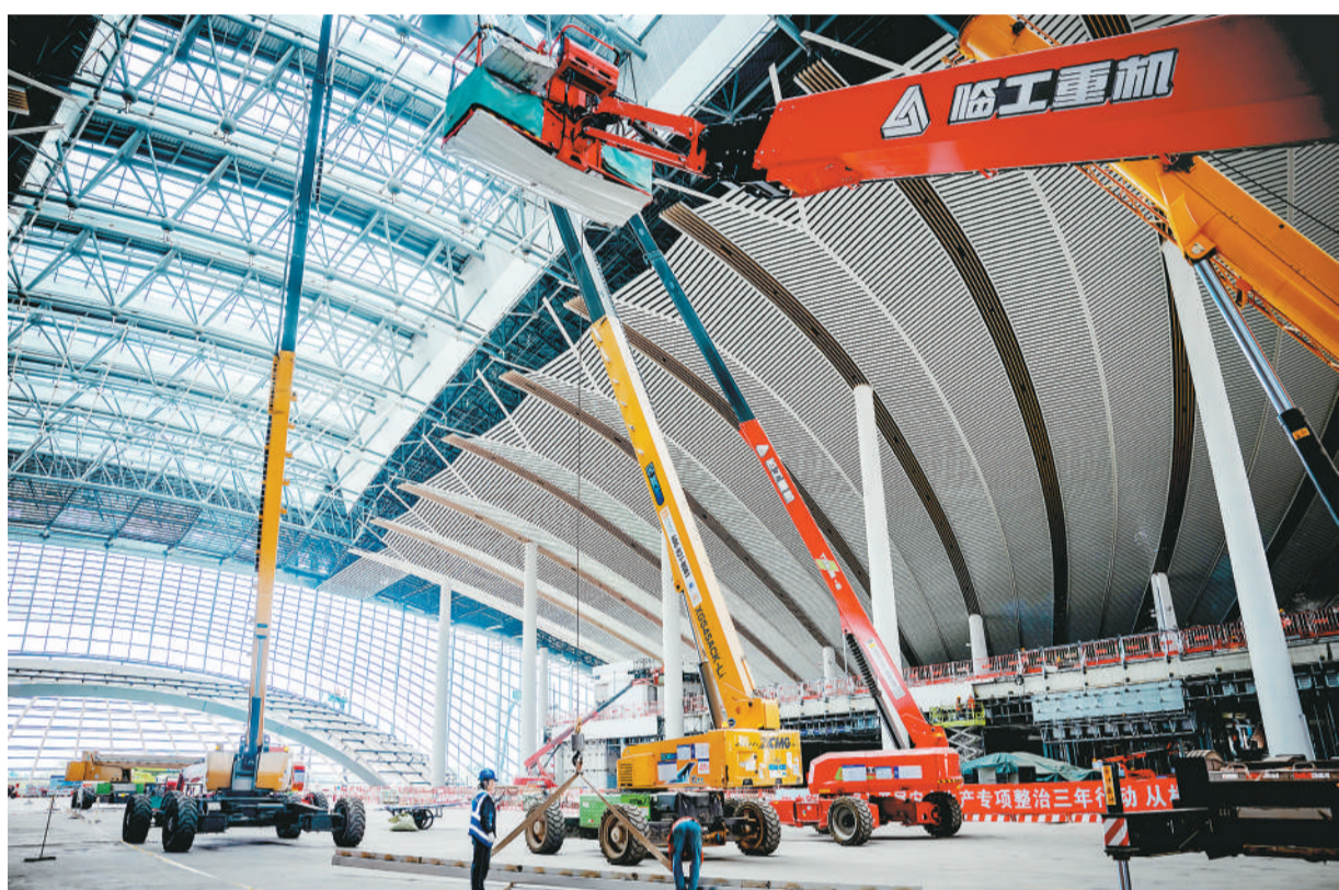
位于成都天府新区的四川省内规模最大高铁站——天府站建设正在进行中。目前，主体结构已完工，外立面幕墙安装超七成，室内装修与机电安装同步推进。该站预计今年底建成，届时将成为成渝地区双城经济圈核心交通枢纽。
