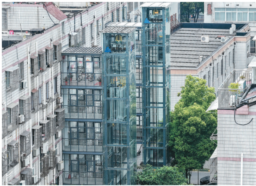
日前，江苏省扬州市某老旧小区完成加装电梯工作。
