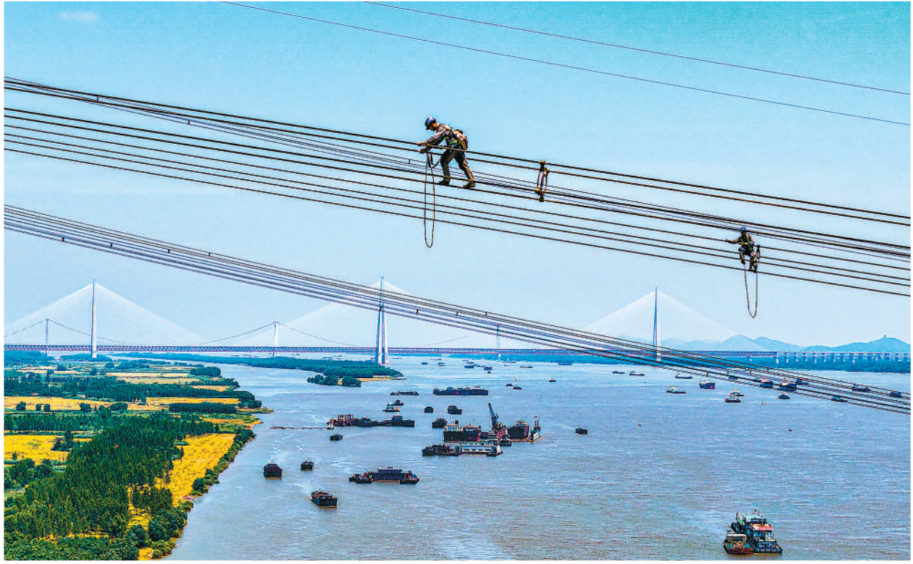
◀五月十日，在安徽省马鞍山市和县至安徽省芜湖市鸠江区长江水域上空，国家电网马鞍山供电公司工作人员对跨越长江的特高压线路进行走线检查。 王文生摄（人民视觉）
