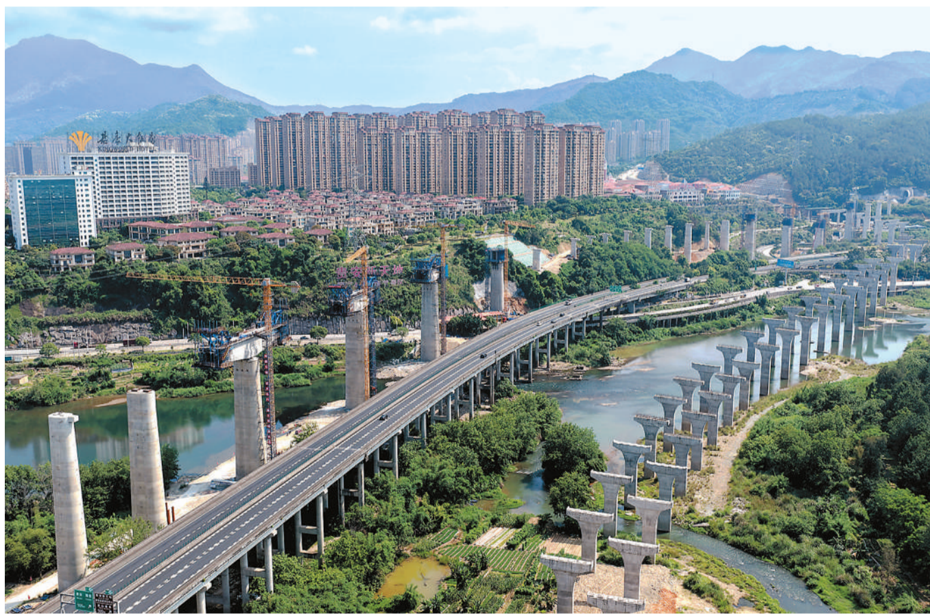
连日来，位于福建省福州市的福州港口后方铁路教江特大桥施工如火如荼，建设者抢抓工期稳步推进各项作业。该铁路建成后，将完善福州港集疏运体系，打通海铁联运“最后一公里”，助力福州打造综合交通枢纽，为福建做强丝路海运、提升沿海开放能级提供有力支撑。
