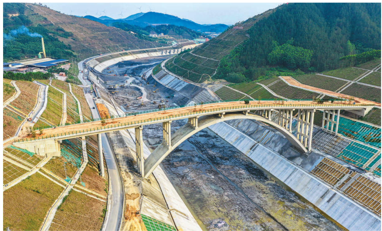
平陆运河野生动物专属通道桥坐落于平陆运河广西钦州市分水岭段，全长240米，既能满足5000吨级航道通行需求，又能适应复杂地形，为斑林狸、豹猫、赤腹松鼠等本土野生动物构建不受运河阻隔的安全迁徙通道，保护生物多样性。图为建设中的平陆运河野生动物专属通道桥。 颜桂海摄(人民图片)
