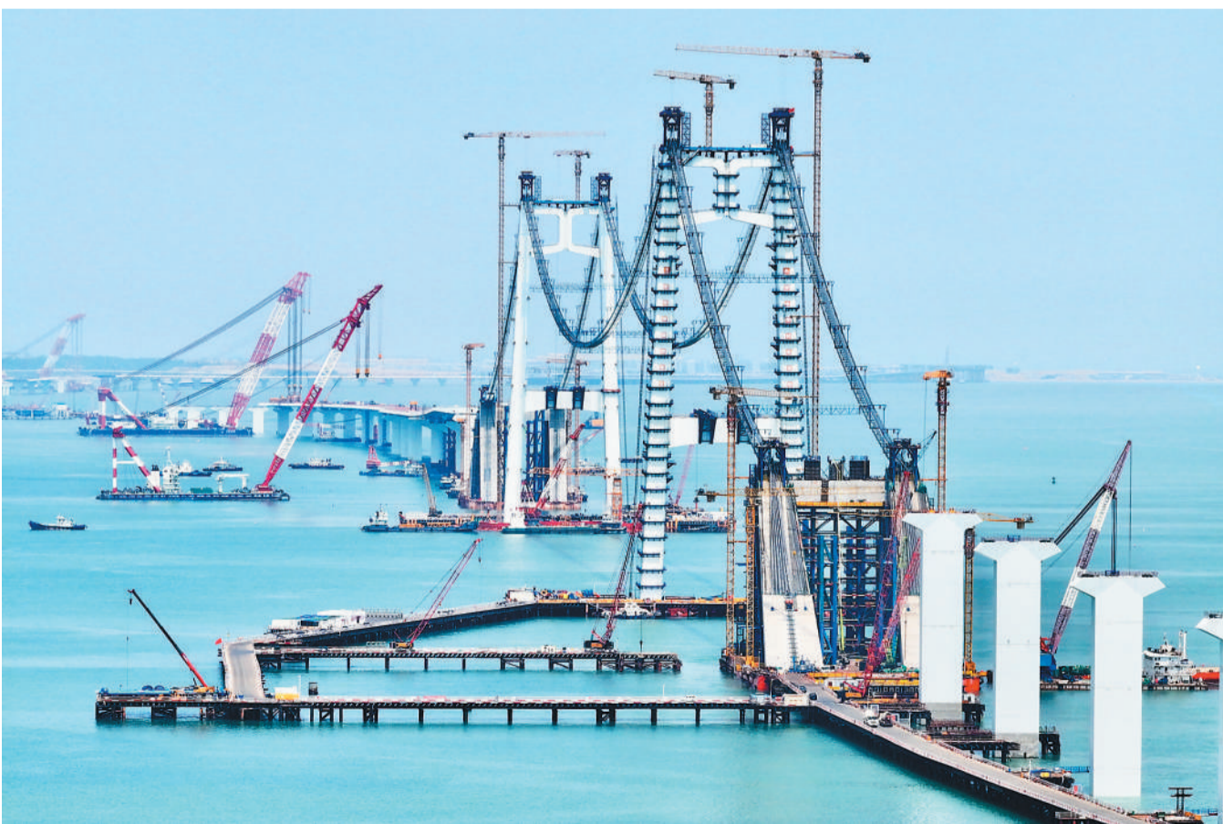
连日来，厦金大桥（厦门段）工程建设有序推进。厦金大桥（厦门段）起于福建厦门环岛东路与会展北路交叉口，终点设互通接入厦门翔安国际机场，并预留至金门段接口，路线全长约19.6公里。图为建设中的厦金大桥（厦门段）。中新社记者 王东明摄
