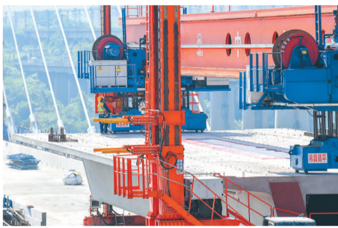
▲ 5月5日,工人在成渝中线高铁进行架梁作业。
