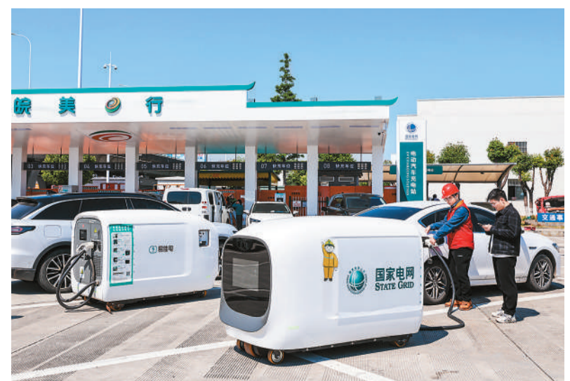
为保障假期高速路网新能源车充电服务的平稳运行,国网安徽省当涂县供电公司在大白岛服务区投放两台移动充电机器人,可同时为4台车充电,单日能服务200台车辆。图为5月1日,移动充电机器人在大白岛服务区为过往新能源车应急补能。 王文生摄(人民视觉)
