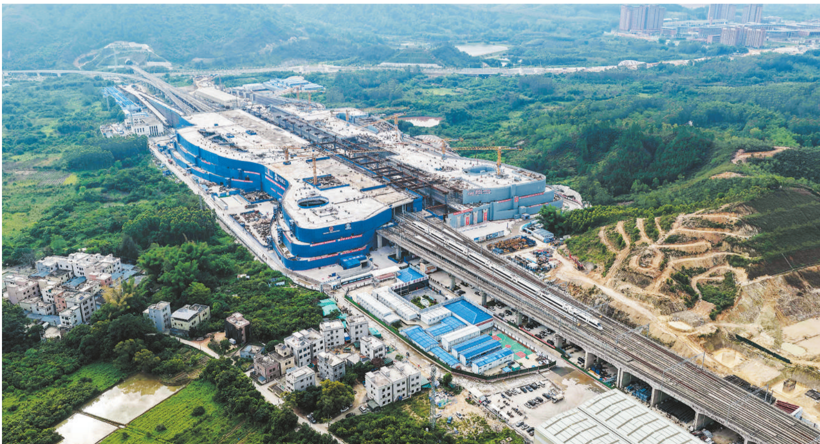
近日，中铁建工集团与中铁北京工程局施工的深汕站广汕场主体结构混凝土结构正式封顶，项目全面转入大跨度屋面钢结构体系和装饰装修样板施工阶段。深汕站位于广东深汕特别合作区，是深汕铁路与广汕铁路的重要交汇点，也是粤港澳大湾区标志性枢纽门户。
