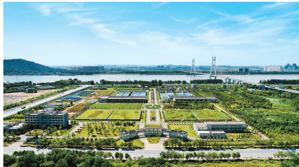
金口水厂实景俯拍。
