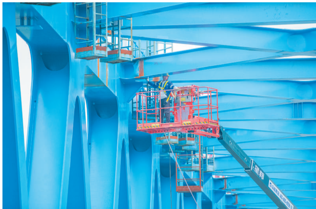
淮宿高铁跨京杭大运河特大桥位于江苏省宿迁市,主桥全长四百六十一米,是全线技术难度最高、施工工艺最复杂的关键节点工程。建成后,该桥将成为世界最大跨度时速三百五十公里高速铁路钢桁梁拱桥。图为大桥施工现场。 徐江海摄(人民日报)
