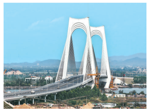
这是3月31日在广西壮族自治区钦州市拍摄的建成通车的平陆运河沙井江大桥（无人机照片）。新华社记者 周华摄
