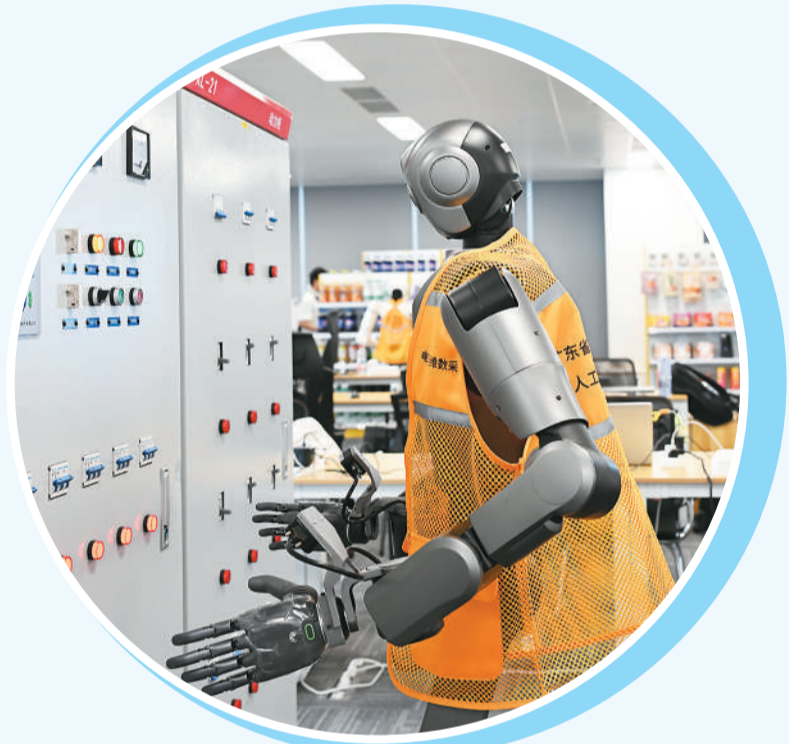
▲ 近年来，广东省持续加大具身智能机器人应用场景适配探索力度，全省初步建立了“关键零部件—整机制造—集成应用”智能机器人全产业链。图为位于广州市海珠区的广东省具身智能训练场内，工作人员在模拟环境下训练机器人进行电力设备巡检与维护。
