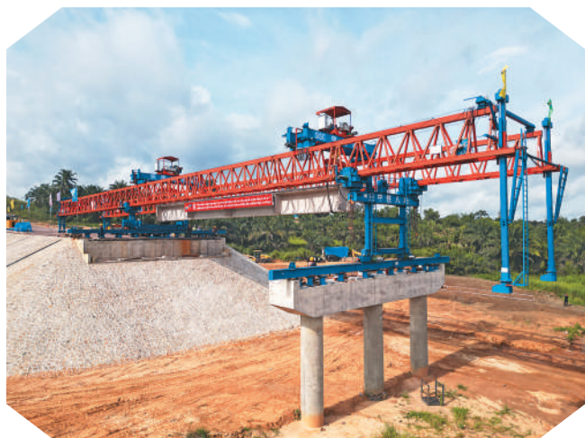
图为架桥现场。
