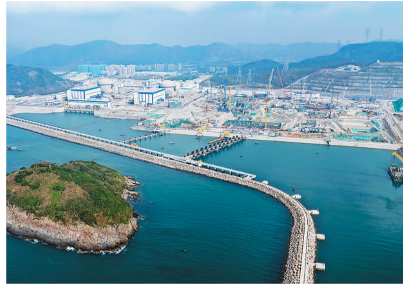
4月20日，粤港澳大湾区首台“华龙一号”核电机组——中广核广东太平岭核电项目1号机组投产发电，正式具备商业运行条件。位于惠州市惠东县的广核广东太平岭核电项目规划建设6台“华龙一号”核电机组，分三期建设，目前整体建设工作正按计划稳步推进。图为中广核广东太平岭核电项目。新华社记者 邓华摄
