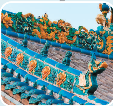
▲张壁古堡空王行祠殿顶上的琉璃构件。
