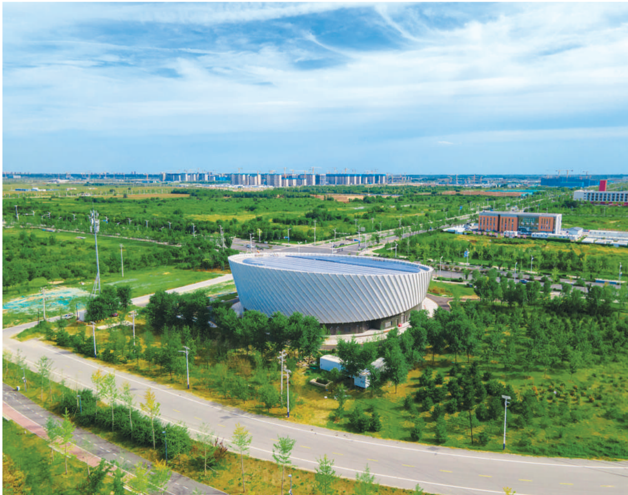
运行中的复兴220千伏变电站。
