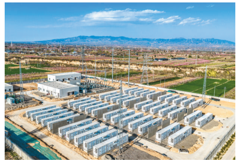
近年来，山西省运城市平陆县加快新能源储能项目建设，推动当地经济绿色低碳转型。图为位于平陆县官厅镇皂坡村的独立调峰调频储能项目正加紧建设。 薛俊摄（人民视觉）
