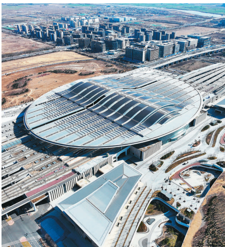
图为京雄城际铁路雄安站。站顶分布式光伏电站总装机容量6000千瓦, 铺设1.77万块、4.2万平方米多晶硅光伏组件。
