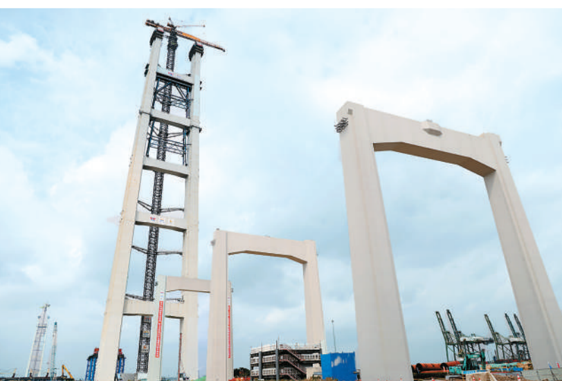
图为狮子洋大桥东主塔。
