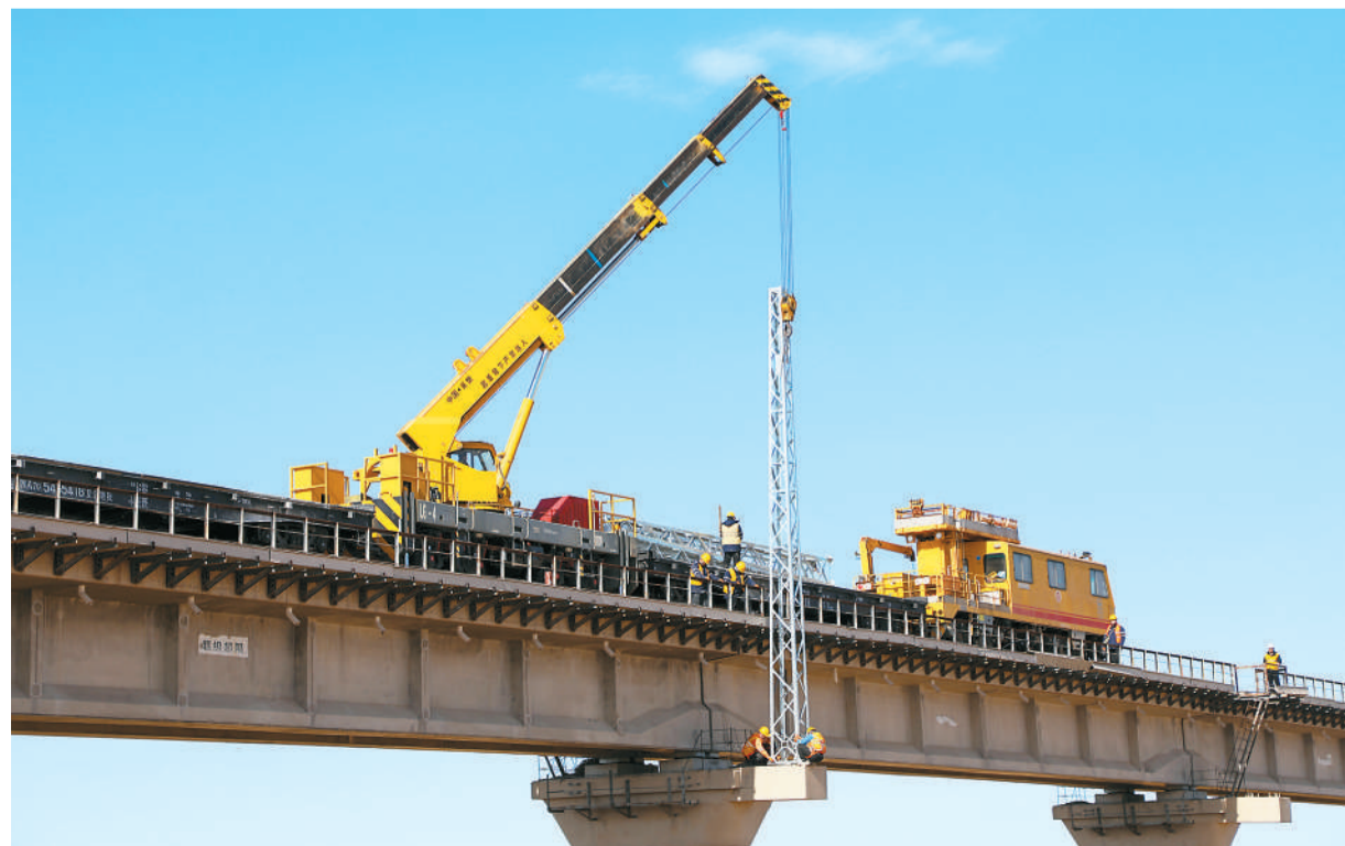
太锡铁路南起河北省张家口市崇礼铁路太子城站，途经张家口市、内蒙古自治区锡林郭勒盟，北至锡林浩特站。铁路全线通车后，将与崇礼铁路、京张高铁共同构成锡林郭勒盟、张家口北部地区进京快速客运通道。图为中铁电气化局建设者在太锡铁路闪电河特大桥，有序开展接触网钢柱安装作业。 孙江昆摄（人民视觉）
