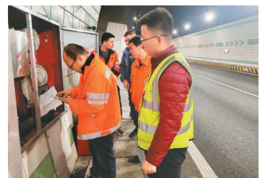
高勇（左一）带队检查消防设施。付强摄
