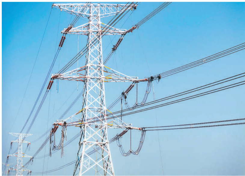
2月12日,在江苏省兴化市海南镇地段,电力工作人员对盐宜高铁通道内500千伏线路进行升高改造作业。 汤德宏摄(人民视觉)
