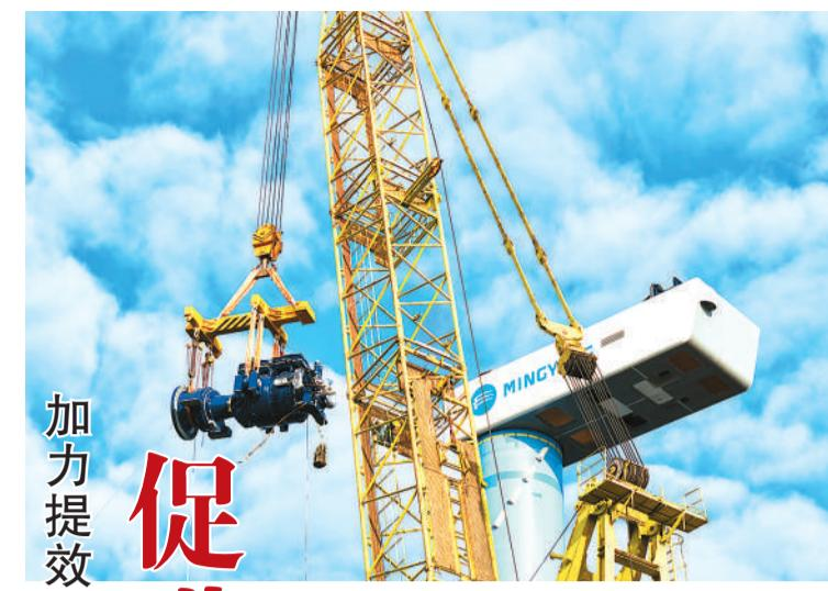
在湖南省衡山县，投资1.6亿元、总装机容量25兆瓦的长江风电场正在建设中。图为项目部施工人员进行齿轮箱的吊装工作。
