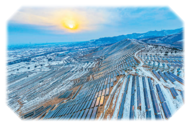
1月21日，在山西省运城芮城县国家光伏领跑技术基地，连绵的光伏阵列在白雪映衬下熠熠生辉。
