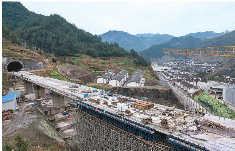
1月30日,西渝高铁渡口大桥完成浇筑,顺利合龙。西渝高铁是全国“八纵八横”高速铁路通道之包(银)海、京昆通道重要组成部分,全长739公里,设计时速350公里。图为在四川省达州市宣汉县境内拍摄的西渝高铁渡口大桥。
