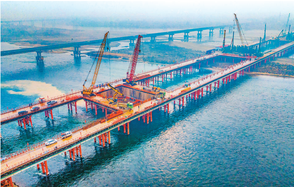
河南洛阳黄河公铁大桥是呼南（内蒙古呼和浩特至广西南宁）高铁焦洛济平段的核心控制性工程，大桥全线总长13.36公里，其中公铁合建段约3.4公里，采用双层结构。图为洛阳黄河公铁大桥建设现场。
