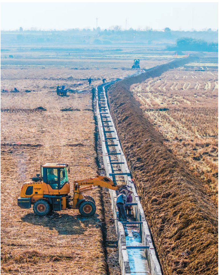
入冬以来，江西省樟树市利用冬闲时节全面推进高标准农田建设，通过田块整治、水利配套等措施提升耕地质量和农田基础设施建设水平，为粮食稳产增收夯实基础。图为施工人员在樟树市昌傅镇太平村修整灌溉水渠。 周 亮摄（人民视觉）
