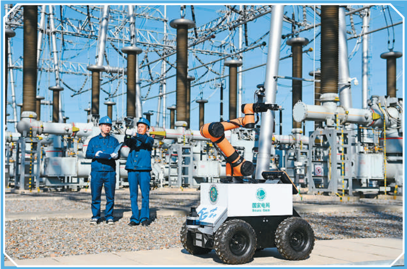
◀在安徽省滁州市南谯区500千伏同乐变电站，一台智能巡检机器人和运维人员进行巡检作业。 宋卫星摄（人民图片）
