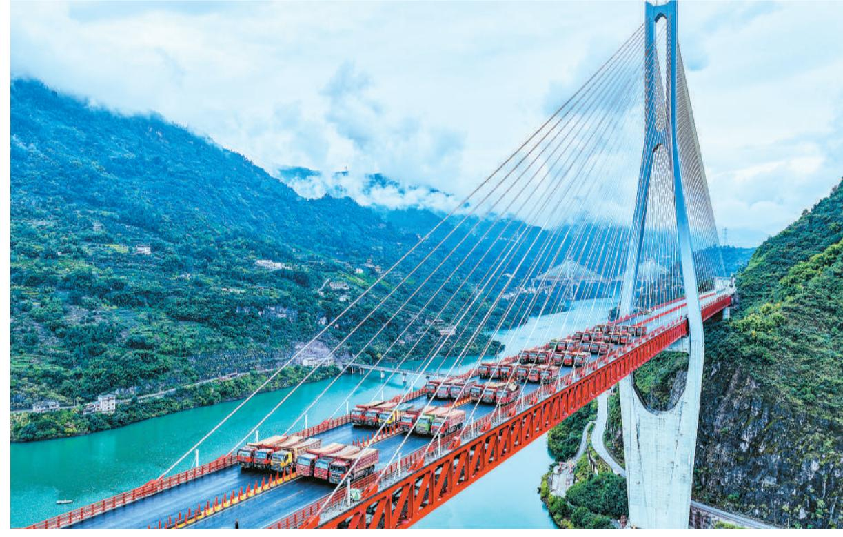
11月14日，四川省宜宾市屏山县新市镇，宜宾至攀枝花高速重要控制性工程——新市金沙江特大桥顺利完成通车前荷载试验，标志着大桥主体结构已具备通车条件。图为大桥荷载试验现场。 张元戎摄（人民视觉）
