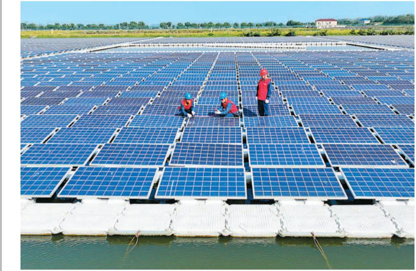
近年来,安徽省天长市依托当地丰富的自然资源,结合渔业养殖面积大的优势,将水产养殖与光伏发电相结合,有效实现了渔业和光伏产业“上可发电、下可养鱼”,促进当地经济、生态双丰收。图为日前,国网安徽滁州供电公司运维人员在天长市秦栏镇牧马湖40兆瓦“渔光一体”光伏电站对运行发电设施进行巡视检查。
