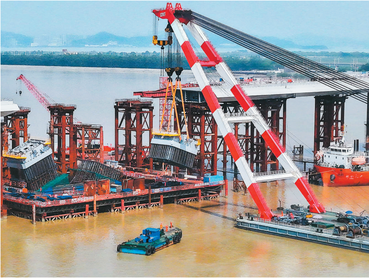
近日，由中铁建大桥局承建的万龙大桥吊装架设首节段主塔。位于广东省广州市南沙区的万龙大桥跨越珠江口龙穴南水道，全长5146米，主桥长1150米，主跨608米，为粤港澳大湾区又一世界级桥梁。图为浮吊船在珠江口吊装万龙大桥主塔首节段钢塔。 新华社记者 刘大伟摄
